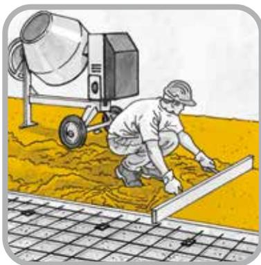
Il getto dovrà essere eseguito con spessore minimo di 4 cm, senza interruzione e, in assenza di confinamento, con adeguata armatura di contrasto. Spessori compresi tra 2 e 4 cm possono essere eseguiti purché il sottofondo sia stato irruvidito e siano stati applicati gli appositi **CONNETTORE 20** a contrasto dell'azione espansiva. Finire la superficie con spatola o staggia. Prima di procedere con l'applicazione di eventuali rivestimenti lasciare stagionare almeno 7 giorni dal termine del getto.
