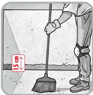
Rimuovere l'intonaco lungo il perimetro della terrazza per un'altezza di 15 cm fino a scoprire la muratura. Procedere con una adeguata pulizia.
