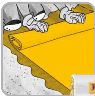
Per migliorare il comportamento elastico è possibile inserire la rete **FLEXONET** "fresco su fresco" sulla 1° mano comprimendola con spatola metallica fino al completo annegamento della stessa.
