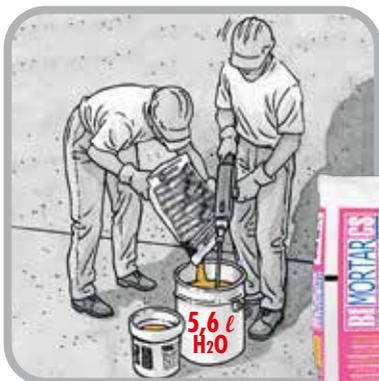
**Preparazione dell'impasto: Bi Mortar Concrete Seal**
