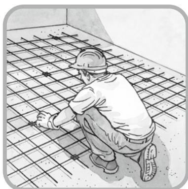
Installare le armature ancorandole al supporto.
