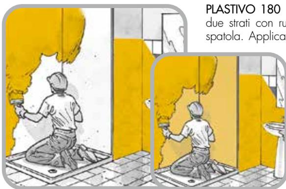
**PLASTIVO 180** deve essere applicato in due strati con rullo, pennello, tiramalta o spatola. Applicare il primo strato per uno spessore di circa 1 mm, avendo cura di fare penetrare bene nel sottofondo il prodotto, per una copertura uniforme della superficie. Il secondo strato va applicato dopo almeno 2 ore per uno spessore di circa 1 mm.
