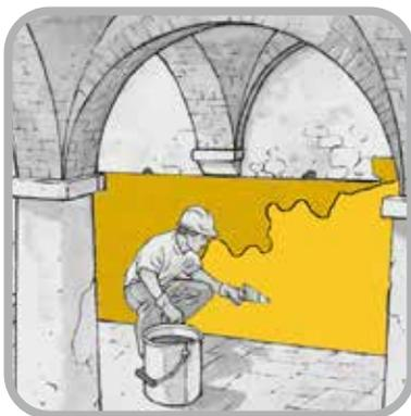
Lo spessore totale del rivestimento può variare da 1,5 cm senza rete in un unico strato fino ad un massimo di 4 cm in due strati con interposta rete **REVOMAT**.
