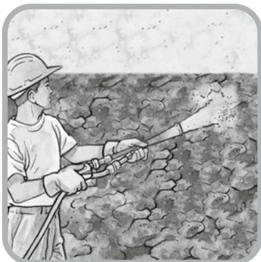
Per garantire un minimo di ruvidità eseguire l'idrolavaggio con acqua in pressione o, dove necessario, con idrosabbatura o sabbatura delle superfici.
