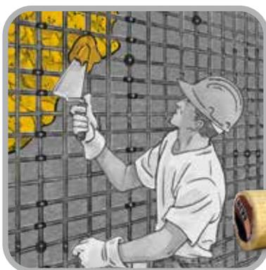
Se previsto annegare nello stesso la rete **REVOMAT** che dovrà essere legata agli appositi **CONNETTORI 20** precedentemente fissati con ancorante **BI FIX 300**. Successivamente applicare un secondo strato di **BI MORTAR PLASTER SEAL** a coprire completamente la rete fino a raggiungere lo spessore desiderato compreso fra 1 e 2 cm.
