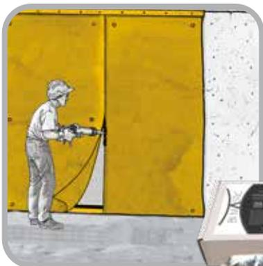
Installare i casseri all'esterno del profilo e procedere alla posa di **AMPHIBIA 3000 GRIP** sul cassero, con la superficie di tessuto non tessuto con la stampa "CONCRETE SIDE" verso il getto da realizzare. Sovrapporre le giunzioni tra telo e telo di 5 cm e fissarle con **BI MASTIC**. Rinforzare gli spigoli e sigillare ogni corpo passante con **AKTI-VO 201**.
