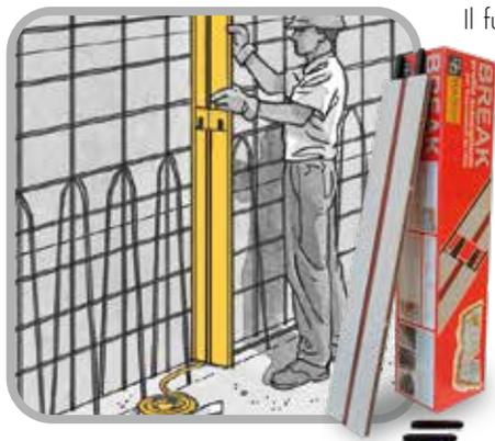
Il fusibile strutturale **BREAK** va posizionato sul punto predeterminato per la formazione del giunto, segnando sul piano orizzontale i punti esterni dell'elemento scatolare, in corrispondenza dei canali di bloccaggio.
