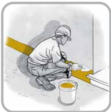
Applicare l'intonaco impermeabile **BI MORTAR PLASTER SEAL** nello spessore di 2-3 cm lungo la zoccolatura.
