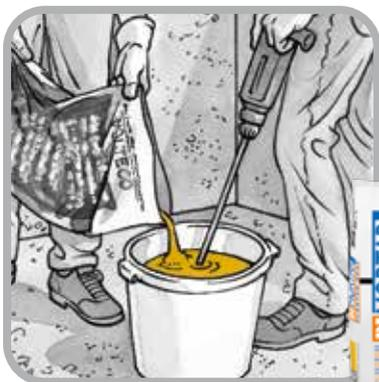
**Preparazione dell'impasto: Bi Mortar Plaster Seal**
