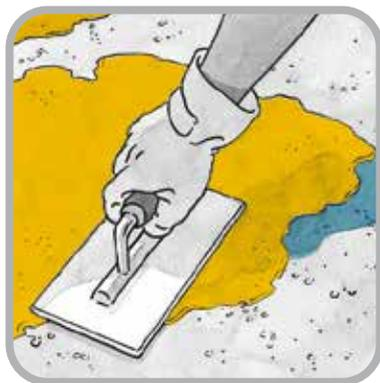
Per ripristinare zone deteriorate, applicare malta **FLEXOMIX 30** in strati non superiori a 2 cm; per l'applicazione di spessori superiori, tra l'esecuzione di uno strato e l'altro, attendere almeno 60 minuti.
