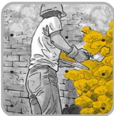
Applicare a cazzuola oppure con intonacatrice un primo strato di intonaco impermeabile **BI MORTAR PLASTER SEAL** di spessore compreso fra 1 e 2 cm, pari a metà dello spessore totale da realizzare.
