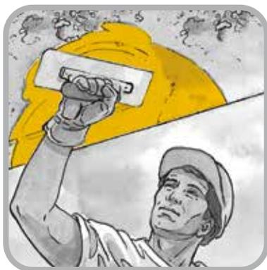
La finitura di FLEXOMIX 30 può essere eseguita mediante frattazzino di spugna dopo circa 40÷50 minuti dall'applicazione.
