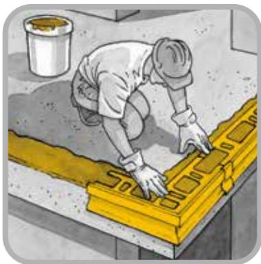
Utilizzare, dove si renda necessario favorire un corretto deflusso delle acque, il profilo gocciolatoio **AQUASCUD LINE** per la finitura e protezione perimetrale di terrazze e balconi.
