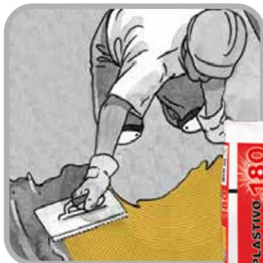
Stendere la prima mano di **PLASTIVO 180** (spessore circa 1 mm) con apposito **FRATTONE DENTATO 3,5 mm** o con **TIRAMALTA DENTATO** con funzione di regolatori di spessore.
