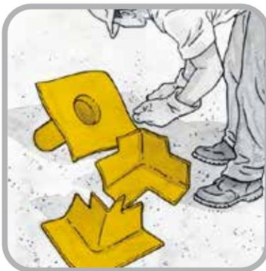
Controllare di avere a disposizione tutti gli angolari e collettori di scarico Volteco necessari per l'intervento.
