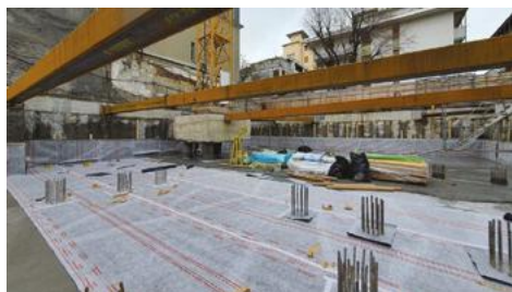
Anno di realizzazione: 2020 Luogo: Gorizia (Italia)
