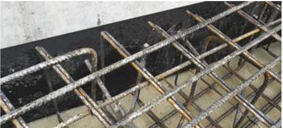
► Posa WT PANEL in gomma idroespansiva per sigillatura testa solaio in c.a.
