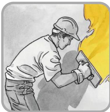
Prima di applicare eventuali rivestimenti, lasciare stagionare **BI MORTAR PLASTER SEAL** per almeno 7 giorni. In ambienti interni, si consiglia l'utilizzo dell'intonaco deumidificante **CALIBRO** oppure, in alternativa, la finitura con il rasante **X-LIME**.
