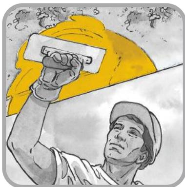
La finitura di FLEXOMIX 30 può essere eseguita mediante fratazzino di spugna dopo circa 40-50 minuti dall'applicazione.
