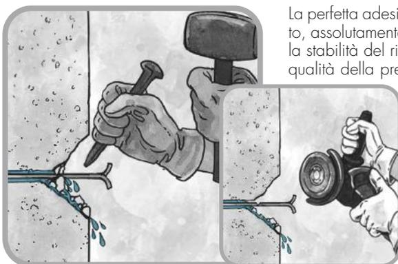
La perfetta adesione al supporto del prodotto, assolutamente necessaria per assicurare la stabilità del ripristino, è in relazione alla qualità della preparazione della superficie sulla quale verrà applicata la malta. Rimuovere accuratamente, ogni parte deteriorata con lo scalpello.
