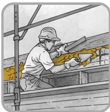
Applicare malta FIBROMIX 40 a cazzuola oppure con intonacatrice in strati non superiori a 3 cm. Per l'applicazione di spessori superiori, tra l'esecuzione di uno strato e l'altro, attendere almeno 60 minuti e inserire idonea rete d'armatura in caso di superfici orizzontali.
