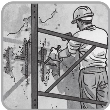
Liberare completamente i ferri per consentire l'applicazione di passivante **SANO-FER** tutto attorno alla bacchetta. Spazzolare energicamente il ferro.
