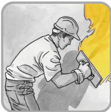
Applicare con spatola metallica nello spessore medio di 1 mm. Attendere almeno 60 minuti fra uno strato e l'altro. Appena la malta inizia ad irrigidirsi procedere alla finitura superficiale con frattazzo di spugna. X-LIME può essere tinteggiato con pittura PAINT AIR.
