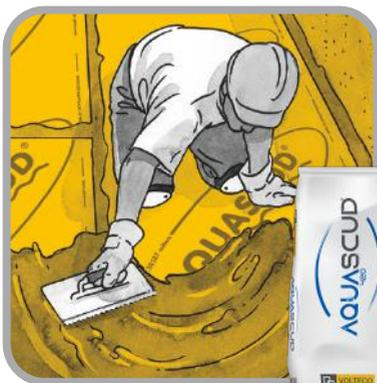
Attendere minimo 30 minuti prima di applicare con **FRATTONE DENTATO 3,5 mm** o **TIRAMALTA DENTATO** un secondo strato della miscela **AQUASCUD 420** in modo da garantire uno spessore minimo di 1 mm avendo cura di ricoprire uniformemente la membrana **AQUASCUD BASIC**.
