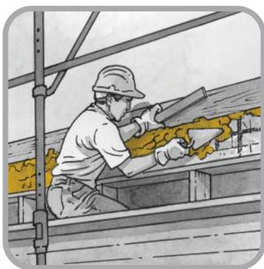
Applicare FIBROeRASO a cazzuola in spessori compresi fra 1 e 40 mm in mano unica. Per l'applicazione di spessori superiori, tra l'esecuzione di uno strato e l'altro, attendere almeno 30 minuti e inserire idonea rete d'armatura in caso di superfici orizzontali.
