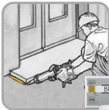
In corrispondenza di soglie ad altezza ridotta intervenire con mastice adesivo **BI MASTIC** o in alternativa con **AQUASCUD JOIN BT**
