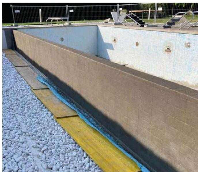
Esempio di impermeabilizzazione **esterna** alla struttura
