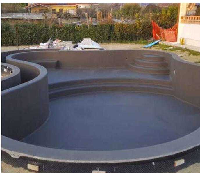
Esempio di impermeabilizzazione **interna** alla struttura
