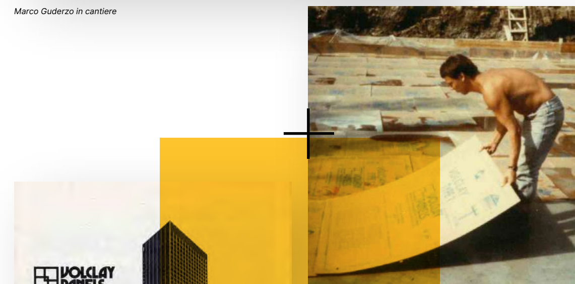
Posa di Volclay Panels
