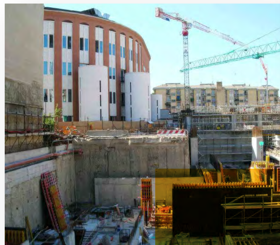
Cantiere dell'Università Bocconi di Milano
