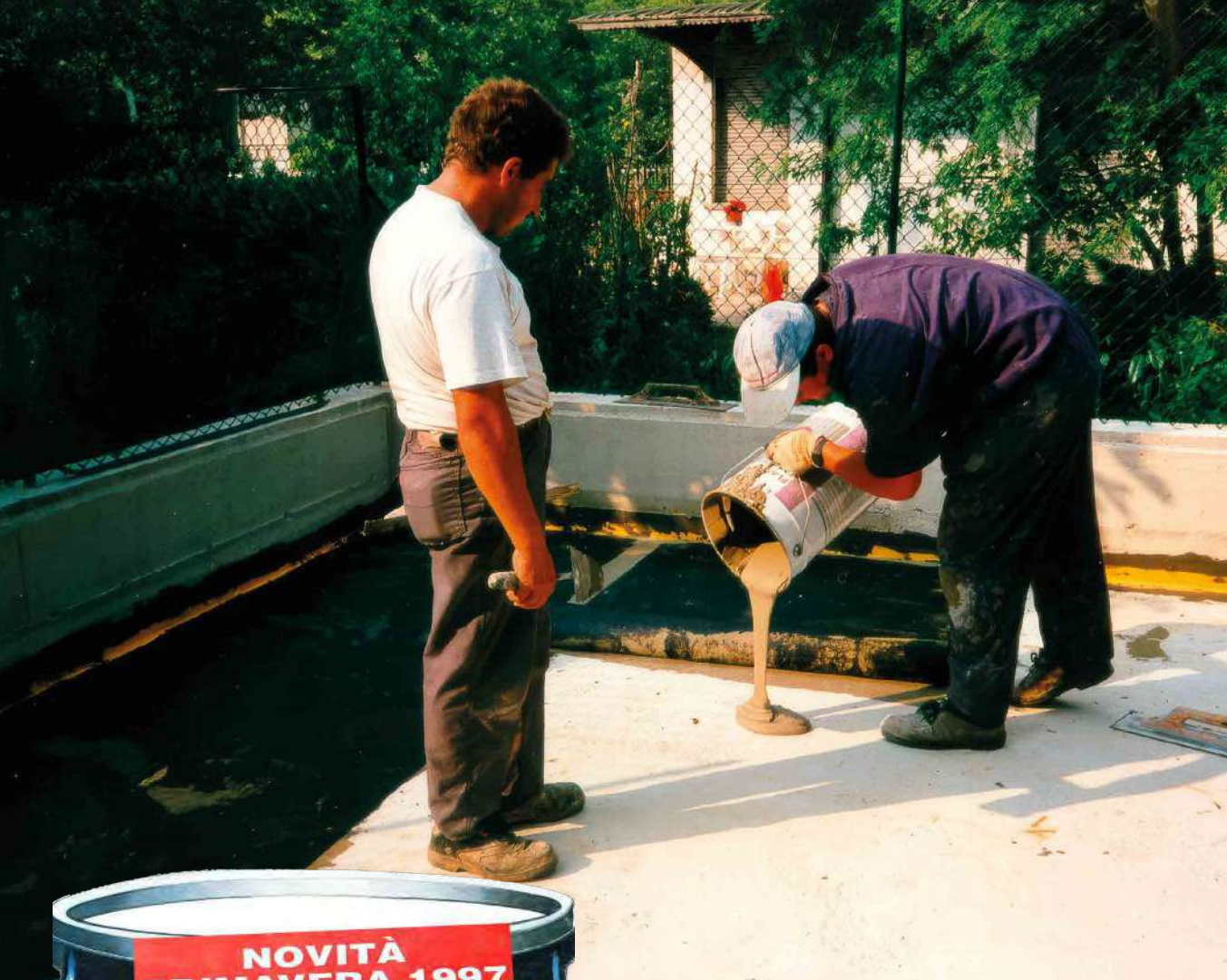
Applicazione di Plastivo in cantiere
