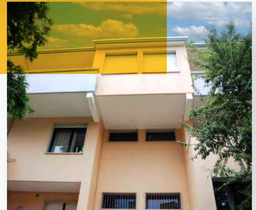
Il primo cantiere di Cp1
