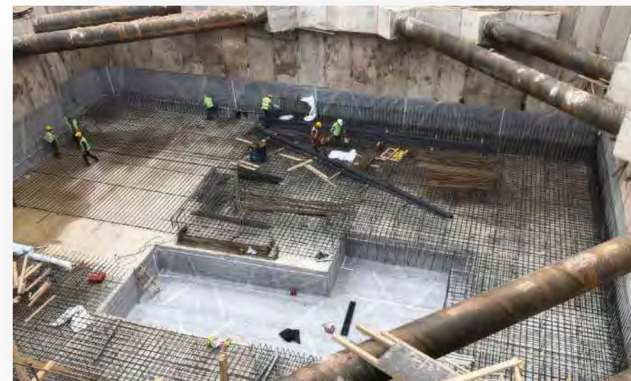
Posa di Amphibia in alcuni cantieri all'estero
